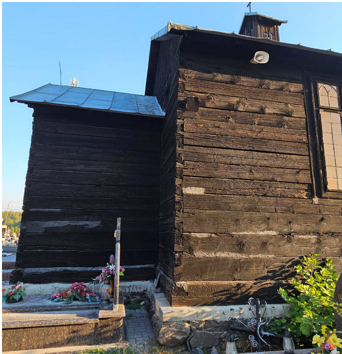
Widok elewacji od strony wschodniej
