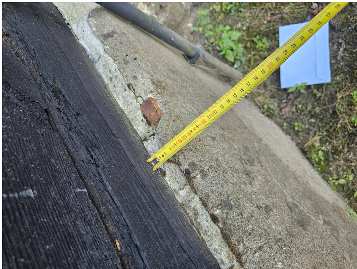
Widok cokołu z wykończonego tynkiem
