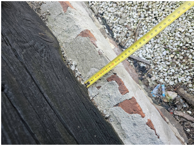
Widok zwieńczenia ceglanego na górze fundamentu
