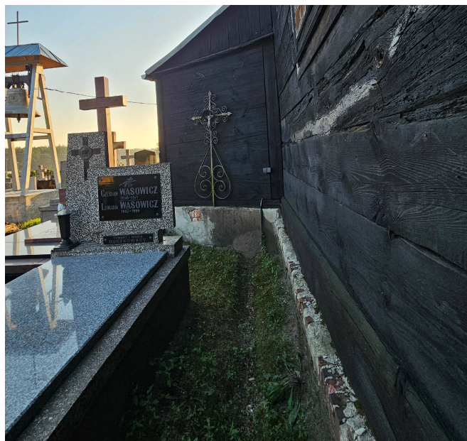
Widok fundamentu od strony zachodniej
